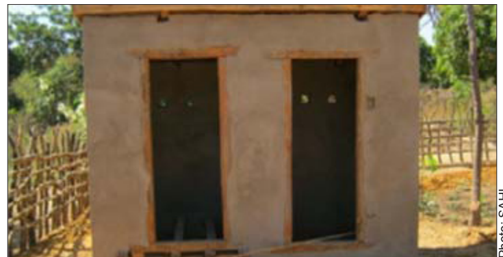
Une latrine fait en brique en pleine construction
