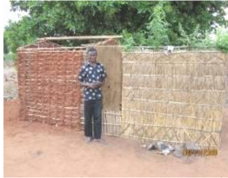
Fig 6: Super-estrutura da latrina tradicional e banheiro
