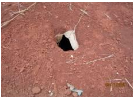
Fig 1: Plataforma da latrina tradicional (em construção)
