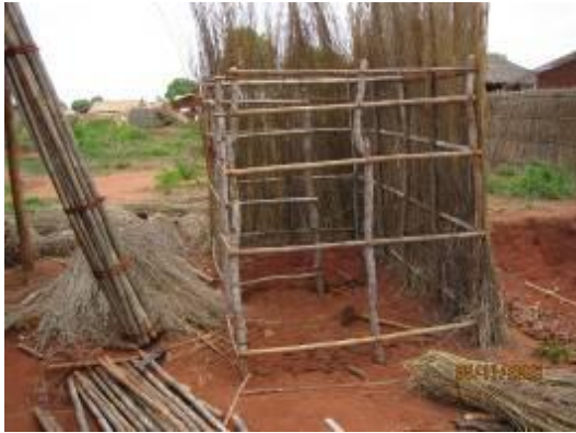
Fig 5: Super-estrutura da latrina (em construção)
