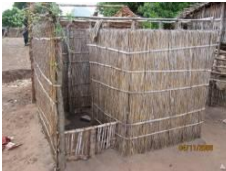
Fig 7: Latrina tradicional completa com capim
