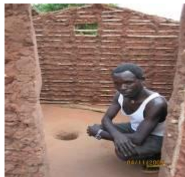
Fig 2: Plataforma da latrina tradicional concluída
