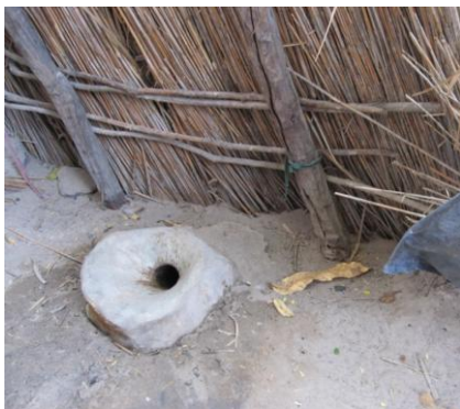
Fig 9: Pour flush latrine
